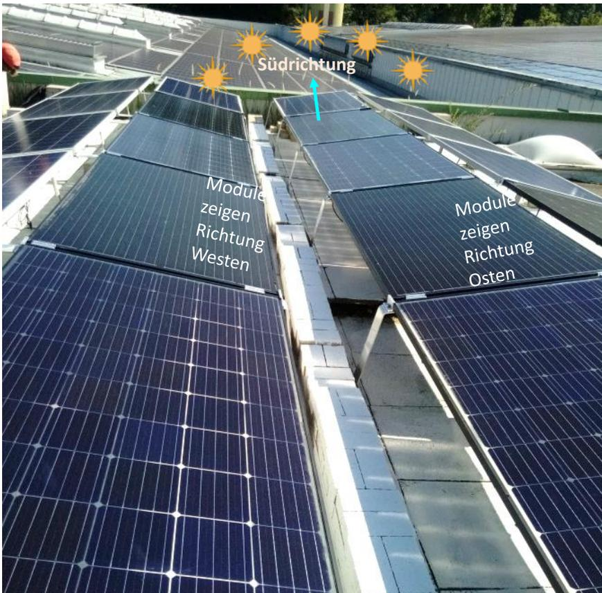
**Abb. 16: Optimierung von verschattenden Anschlussdosen, Rahmen und Bifazialität**
