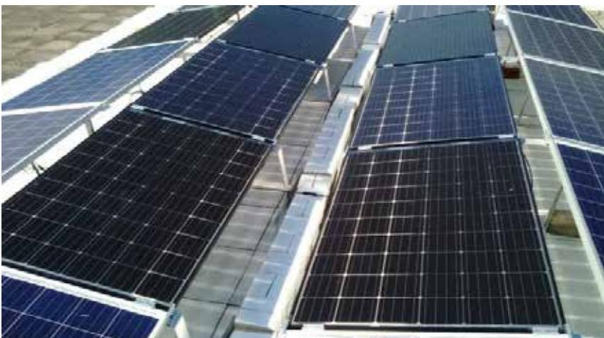
**Abb. 4: Foto aufgeständerte bifaziale PV Module auf Flachdach (System G+: Alumero, AT)**
