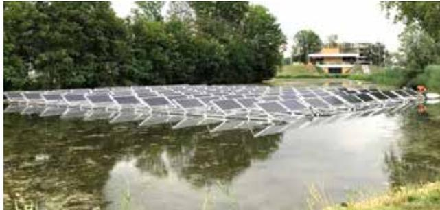
**Abb. 2: Aufgeständerte bifaziale PV Module auf Wasseroberfläche (Quelle Sunfloat, NL)**
